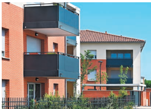
RÉSIDENCE BELLEVUE À SAINT-JORY (31) - 77 LOGEMENTS
